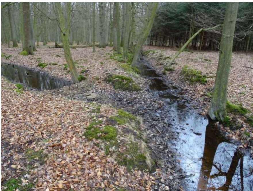
Grabenverschluss im Rahmen der Wiedervernässung (Bildquelle: Dirk Bieker aus AFZ-Der Wald 2/2018)
